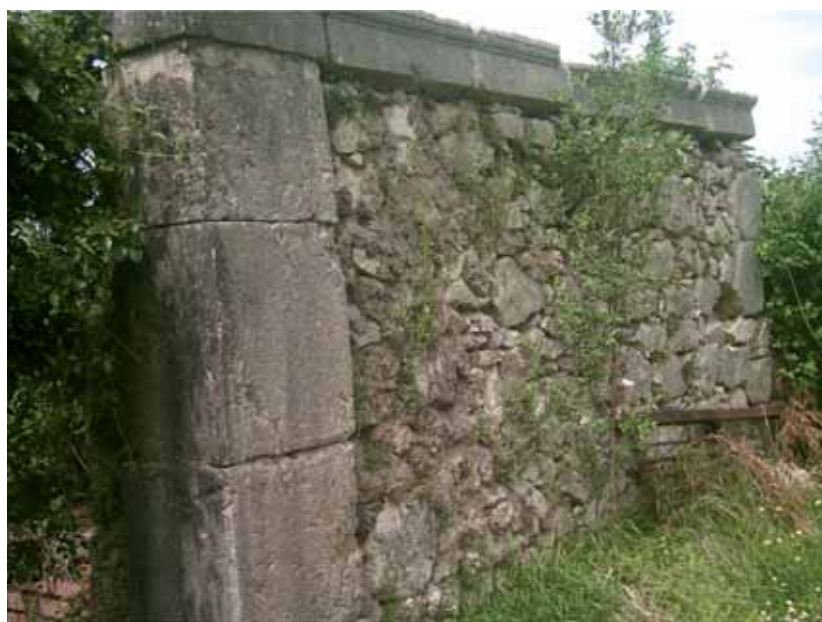
B. Resti della chiesa di San Savino reimpiegati nel muro di cinta del vecchio cimitero abbandonato di Castelmenardo.
