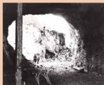
Ingresso della galleria di collegamento dei laghi Salto e Turano in costruzione nel 1938 (Collezione P. D'Alessandro, Rieti)
