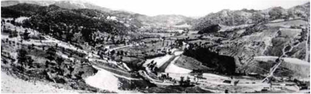
La Valle del Salto al momento dell'avvio dei cantieri per la costruzione della diga
