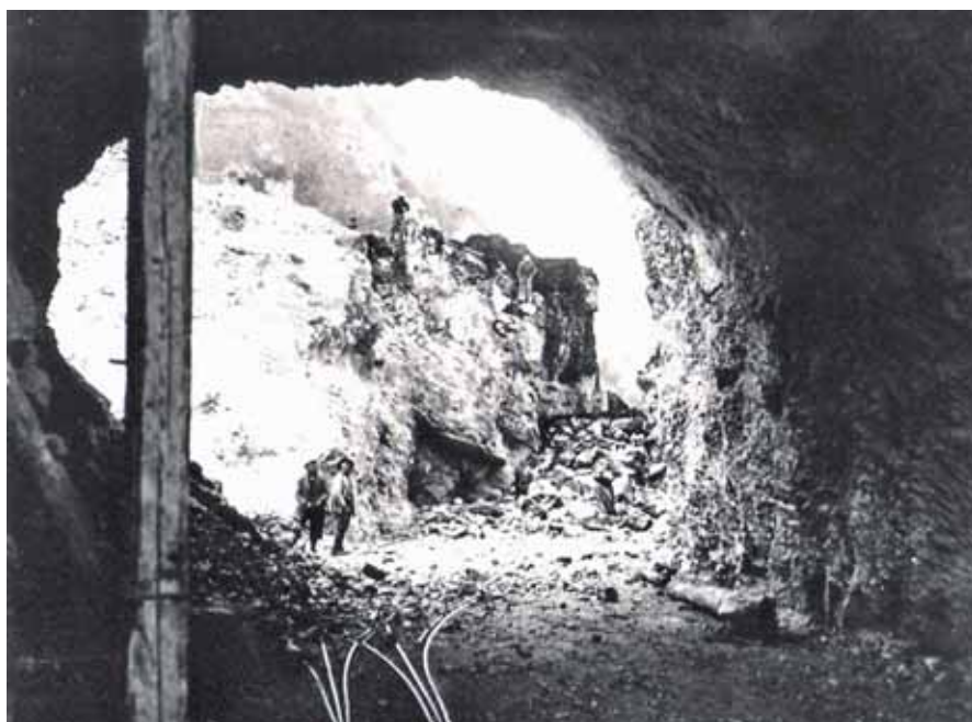
Cantiere della galleria di collegamento tra i due bacini artificiali in costruzione (Collezione P. D'Alessandro, Rieti)
