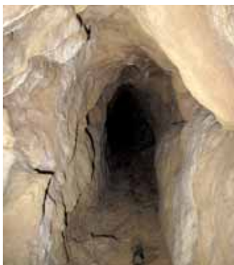
Fig. 3 - In primo piano il tubo di ghisa all'interno del cunicolo
