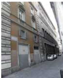
Fig. 13 - Il monumentale palazzo Lazzaroni in Via dei Barbieri 6, come appare oggi, sede dello studio romano di Venceslao Amici (foto valledelsalto.it giugno 2013)
