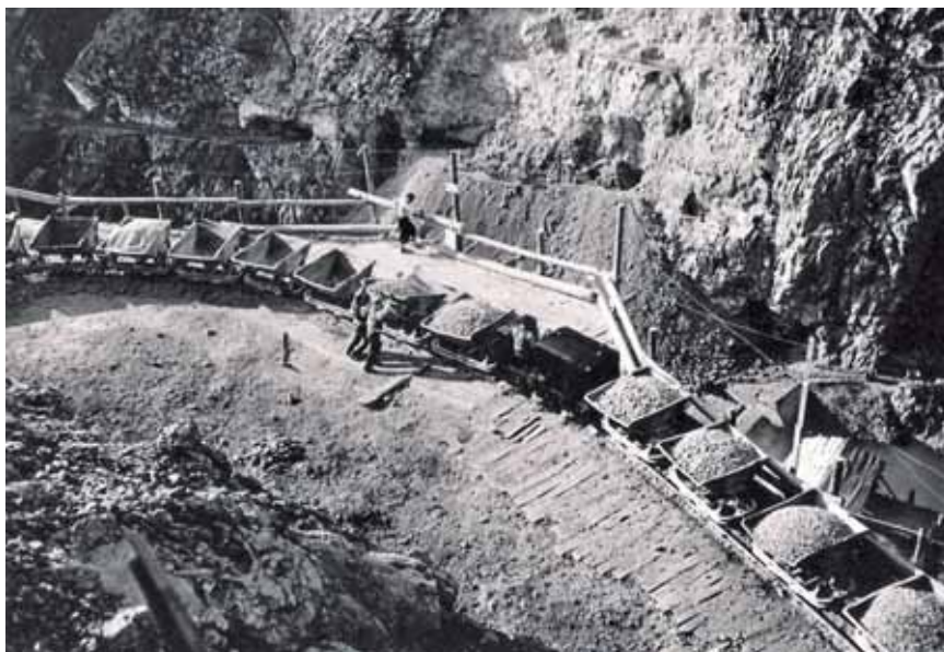
Cantiere della diga del Salto (Collezione V. Scaccia, Rieti)
