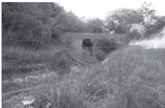
Ponte ad una luce nei pressi di Fiumata
