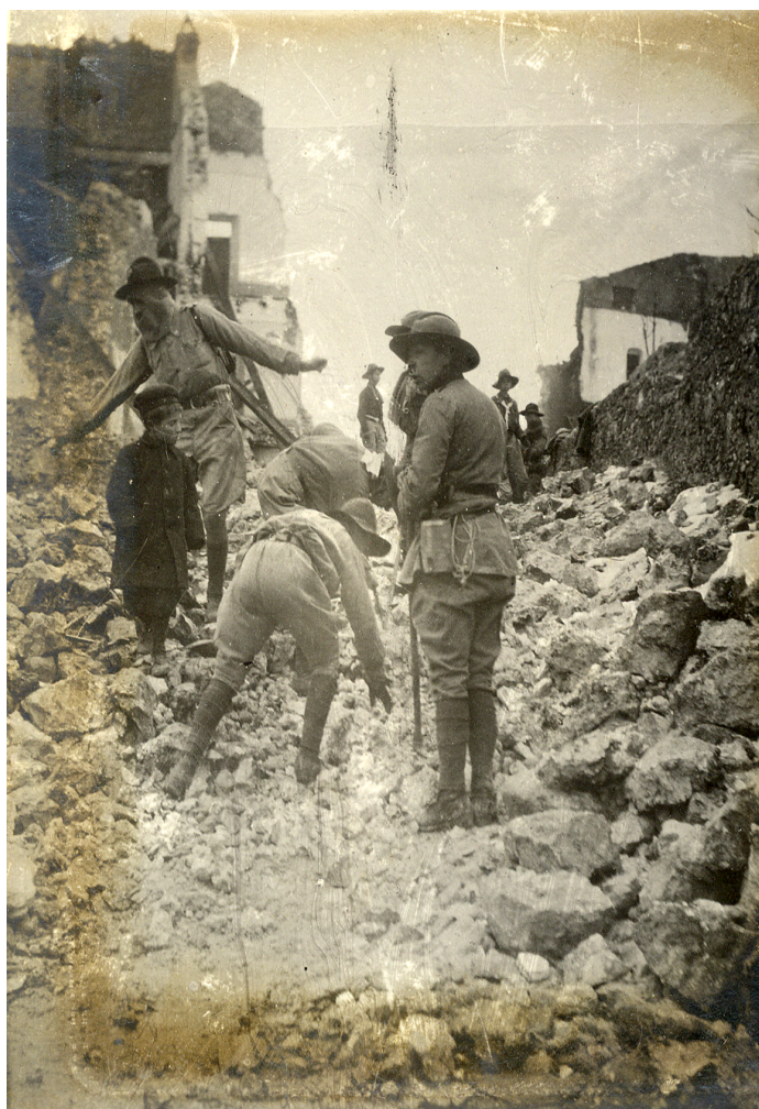
Fig. 2 - Civita d'Antino 20-21-23 gennaio 1915 sgombero di una via (Archivio centrale dello Stato)
