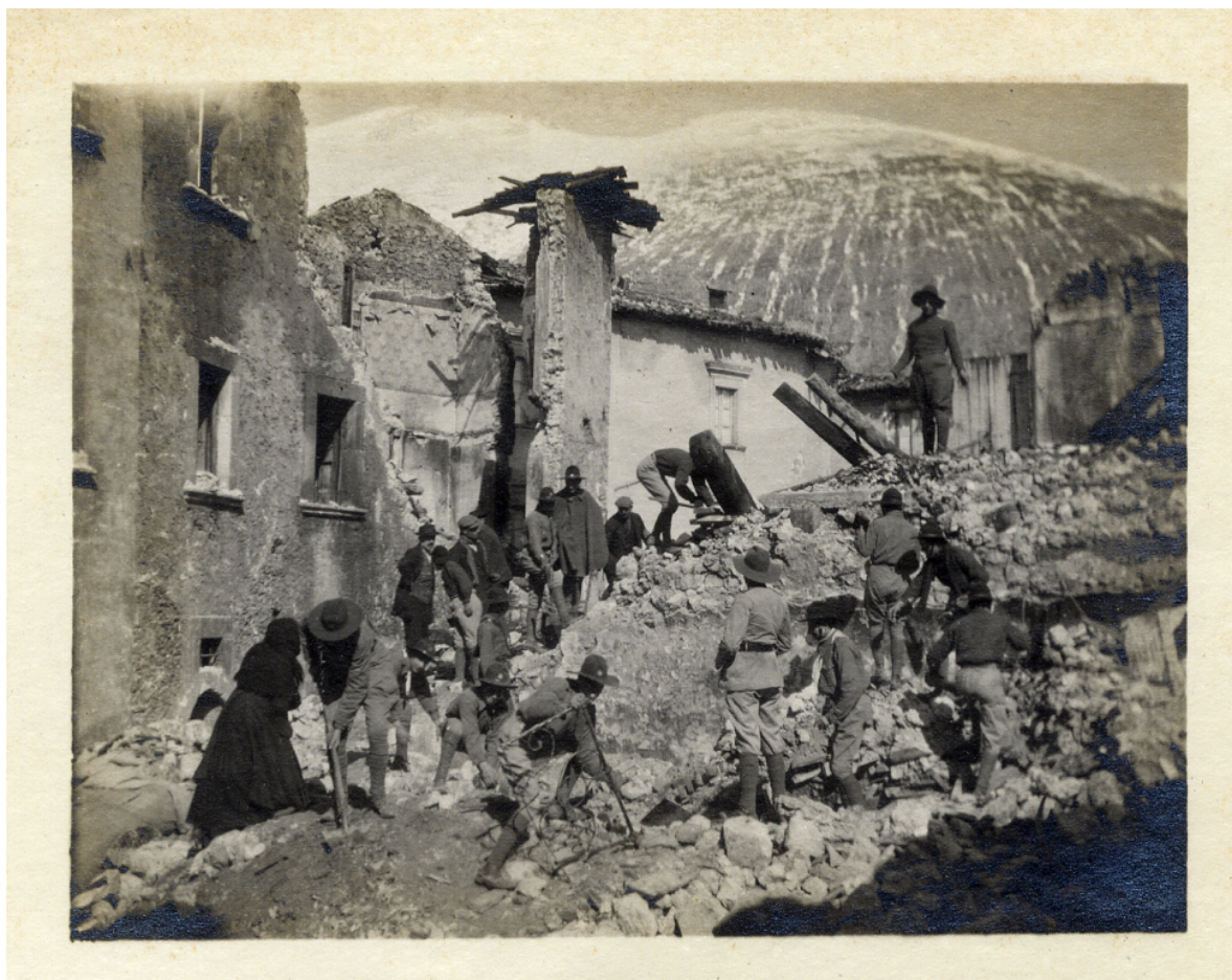
Fig. 4 - Corona 27-28 febbraio 1915 sgombrò macerie (Archivio centrale dello Stato)
